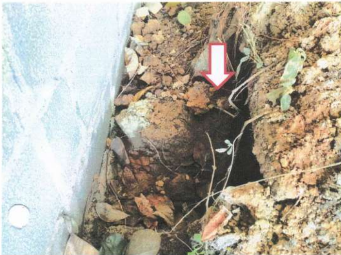
ปลายรางระบายน้ำทิ้งระบบประปา
