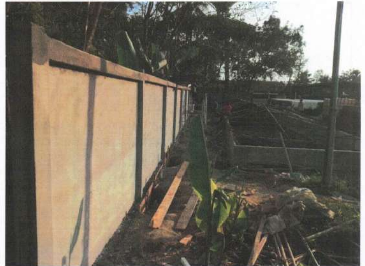
คาน/ผนังคอนกรีตกันน้ำซึมผ่าน
